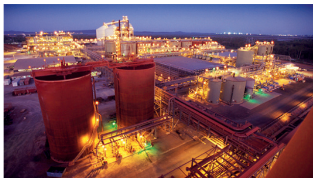
Abb. 6: Gladstone Tonerdefabrik in Australien, Foto: Rio Tinto.
